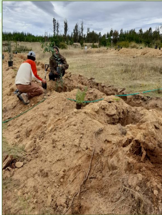
Fotografías de zanjas de infiltración en curvas de nivel en predios reforestados en la comuna de Cauquenes. CAEL 2021-2022.
